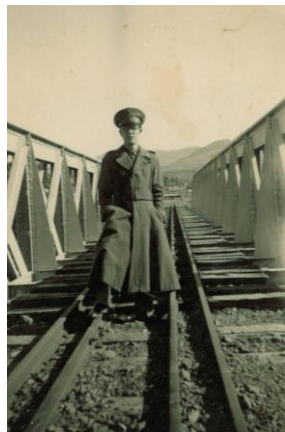
Imagem 2 - Fausto Koetz. Ponte sobre o Rio Paranhana – 1960
