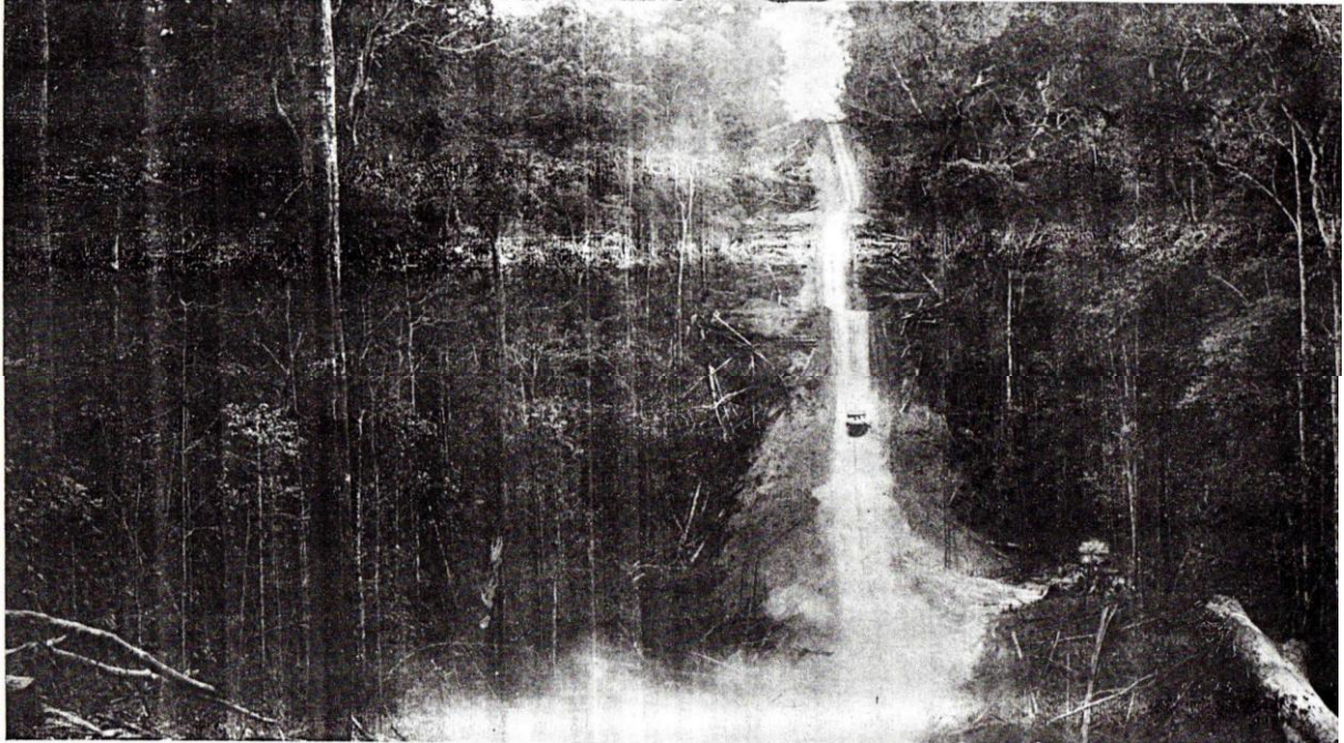
Figura 9 – Trecho com topografia ondulada entre Belém e Imperatriz antes desconhecido pelos construtores.
